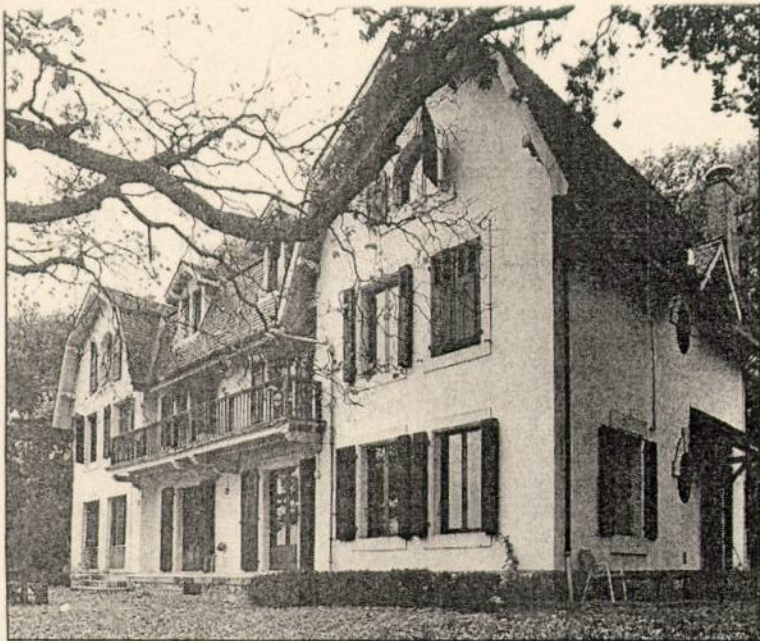
Dans l'ancienne villa Rappard, le centre offre un service de documentation et d'information et peut abriter entre trente et quarante délégués. Christian Murat
